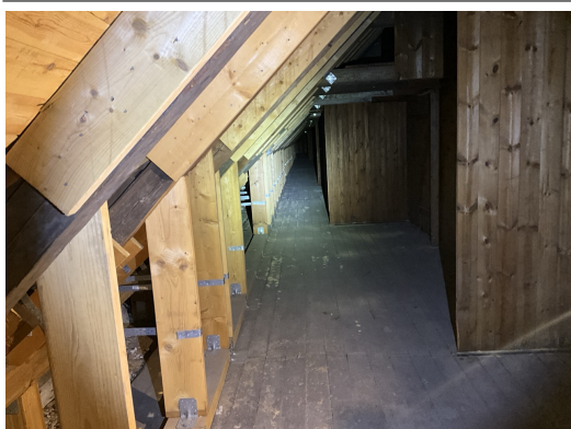
Store brandsektioner i loftrummet.
