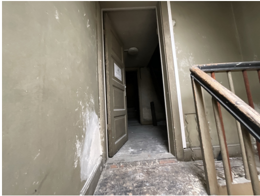
Åbenstående dør mellem bagtrappe og loftrum
