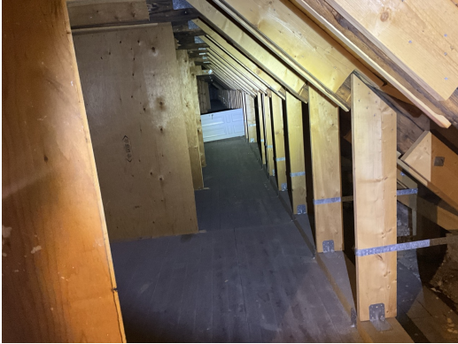
Store brandsektioner i loftrummet.
