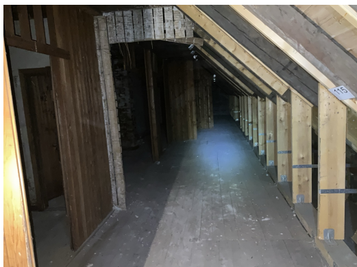
Store brandsektioner i loftrummet.
