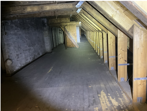
Store brandsektioner i loftrummet.
