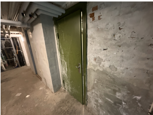
Åbenstående dør mellem kælder og bagtrappe
